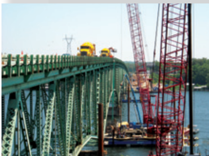
Drilled shaft pour
